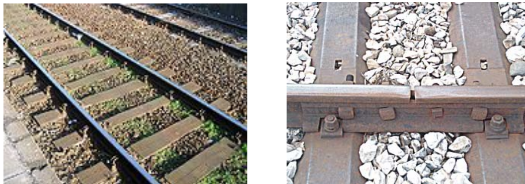
Rysunek 31. Tradycyjne torowisko kolejowe na podkładach drewnianych lub betonowych z przerwami między odcinkami szyn.
