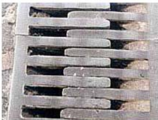
Rysunek 34. Dylatacyjne „grzebienie” w konstrukcji mostu.
