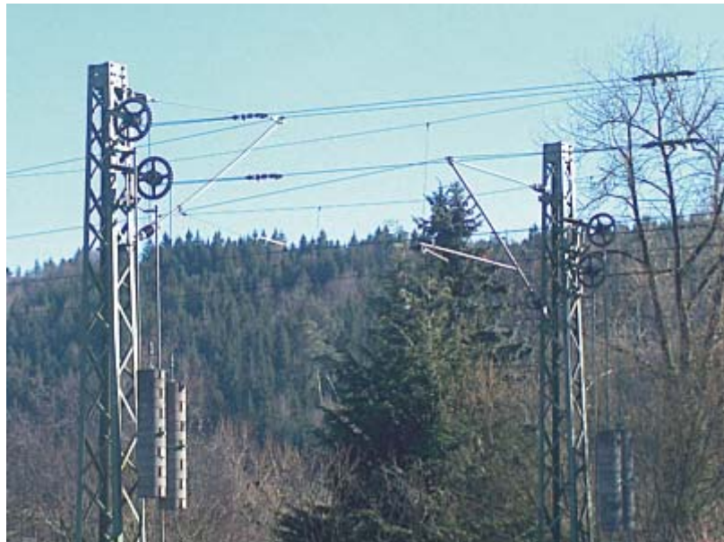
Rysunek 33. Sposób kompensacji termicznych zmian długości przewodów trakcji elektrycznej.
