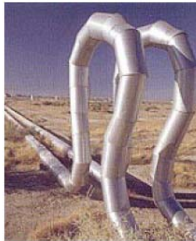
Rysunek 36. Kompensacja termicznych zmian długości rurociągów.
