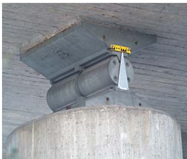
Rysunek 35. Podparcie przęsła mostu umożliwiające swobodny ruch przęsła.
