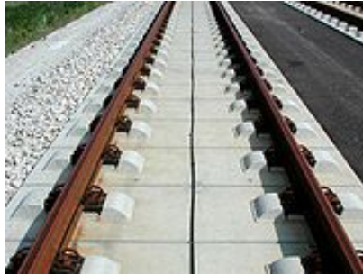
Rysunek 32. Torowisko z szynami ciągłymi dostosowane do szybkiej kolei.
